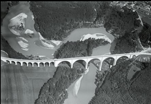
Le pont de Pérolles, un ouvrage routier en béton, près de Fribourg, pris en 1926
