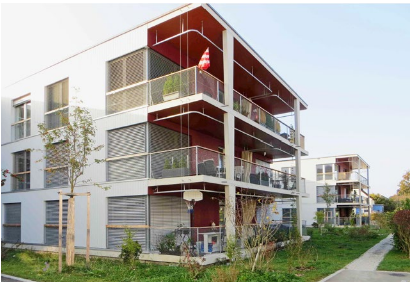
El complejo residencial de Brüggliacker, en Schwamendingen, desarrollado por una cooperativa de construcción de viviendas, está situado junto a un barrio tradicional de casas unifamiliares.
