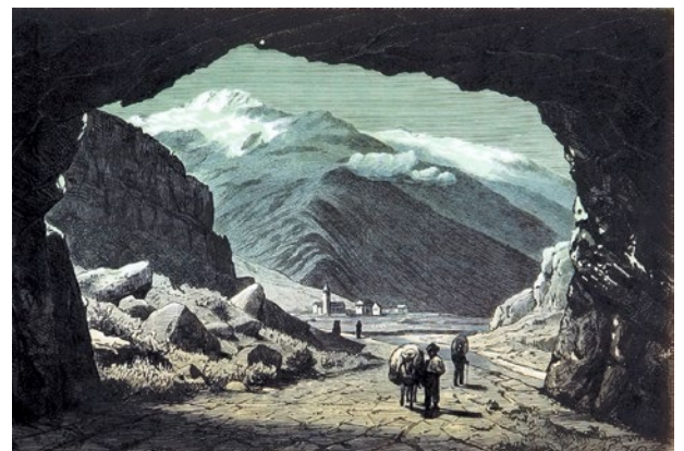
Una ilustración romántica del Urnerloch, el primer túnel carretero de los Alpes.
