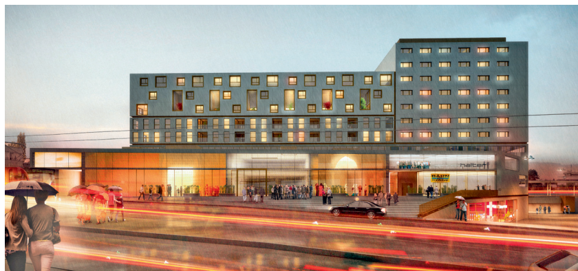
Imagen de la construcción en la Plaza de Europa de Berna, que albergará la Casa de las Religiones
